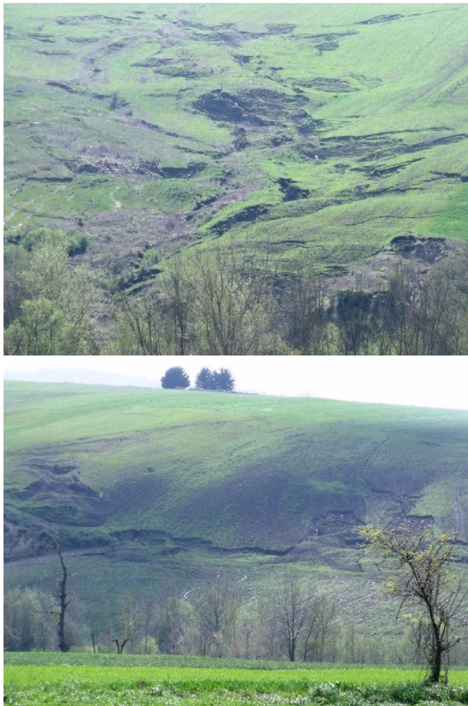
Fig. 21 - Fenomeni di dissesti di varia natura presso Migliano, in territorio di Frigento, al confine con la Contrada Carmasciano di Rocca San Felice (erosione in alveo, colamenti, soil creep ).
