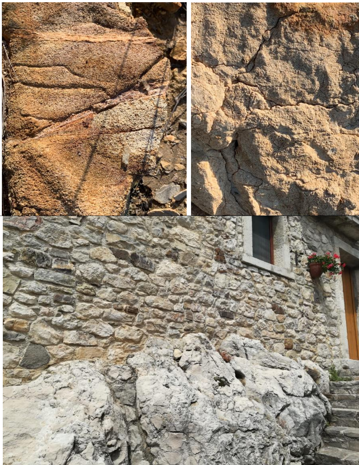
Fig. 13 – in alto, le arenarie turbiditiche giallastre del FYN presso il lago della Mefite, del quale costituiscono il pianoro; in basso, il substrato calcarenitico del centro storico di Rocca, costituito dai depositi del membro calcareo del Flysch Rosso (FYZ): su di esso poggiano direttamente i fabbricati storici, privi di strutture fondali.
